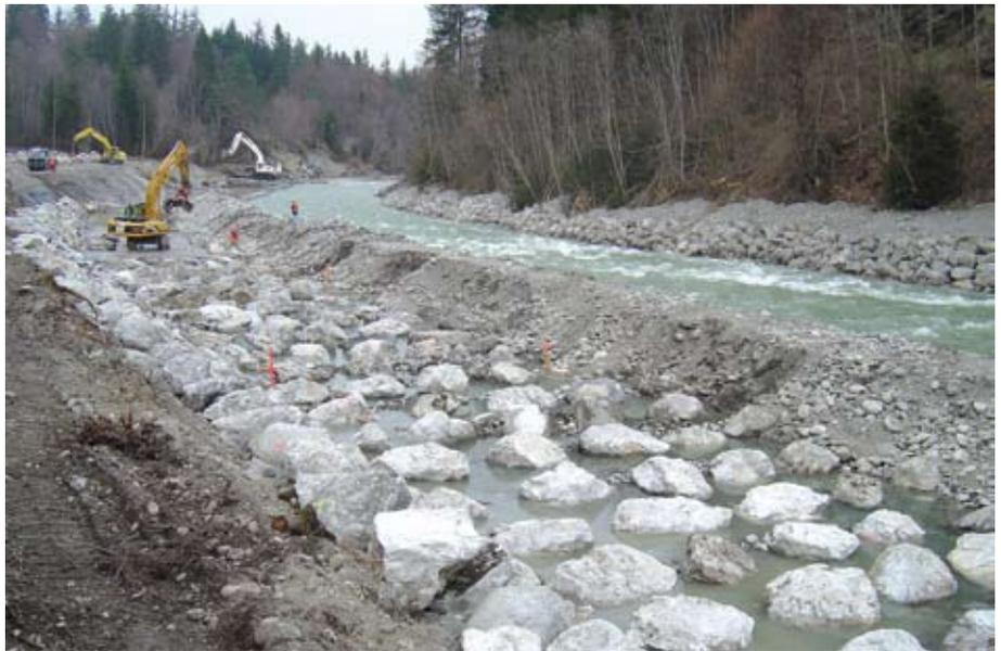
**Bild 15. Umleitung Kander über bereits fertig gestellten Teil der Blockrampe und Bau der zweiten Hälfte.**
