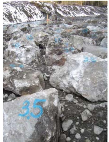
**Bild 18. Bauüberwachung und Qualitätssicherung, angeschriebene Massen auf Einzelblöcken.**
