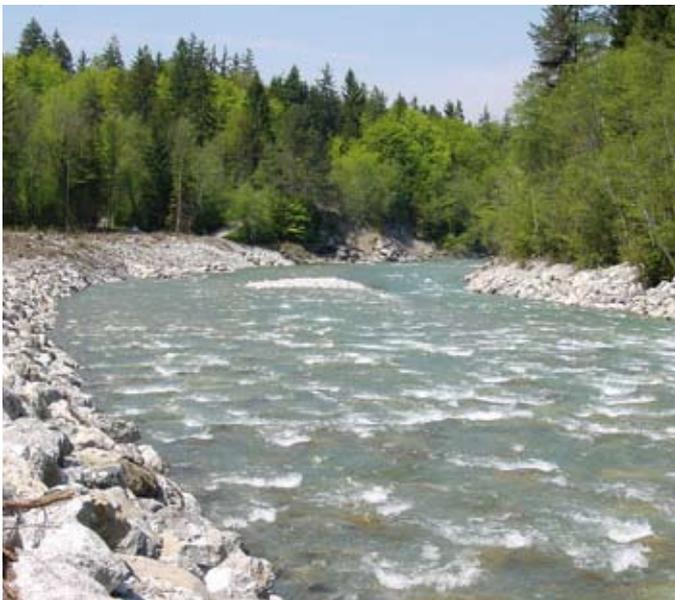
**Bild 21. Blick flussaufwärts auf die fertige Blockrampe.**
