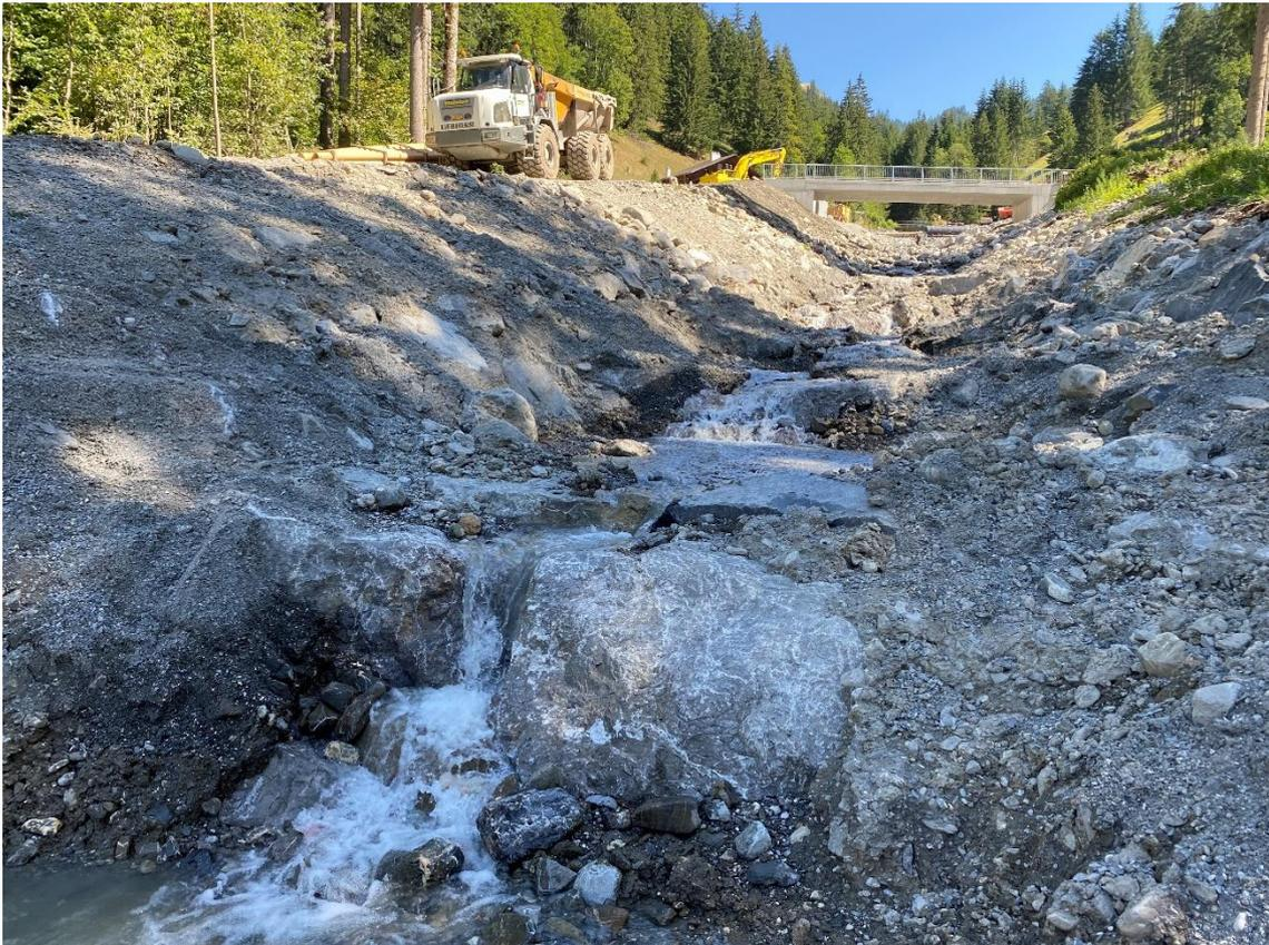
Gebaute Stufen-Becken-Abfolge am Betelriedbach im August 2022 kurz nach der Erstellung (Foto: Theiler Ingenieure AG)
