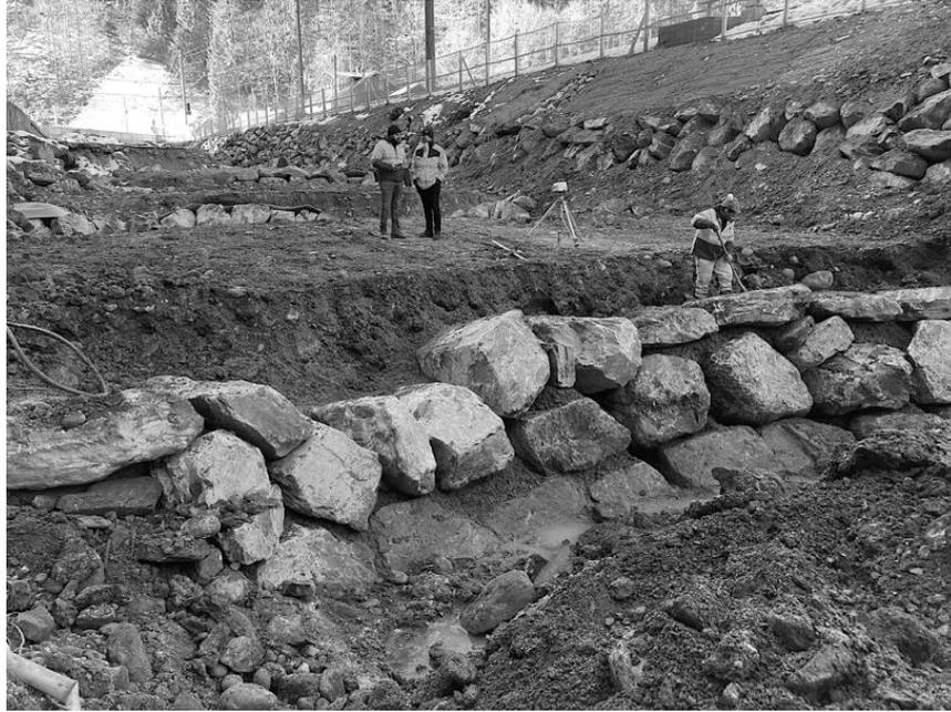
Abb. 6: Blocktraverse im Bau. Blöcke werden in Hinterbeton gelegt, die Niedrigwasserrinne wird jeweils einseitig angeordnet. (Bild: Mätzener & Wyss Bauing. AG).
