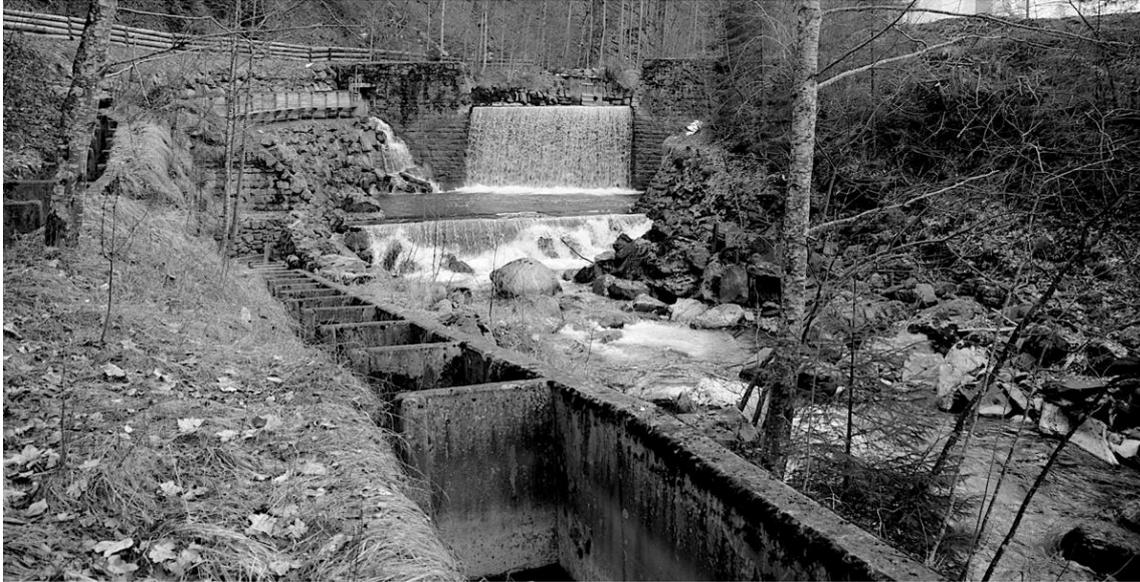
Abb. 1: Baufälliges Sperrensystem mit Haupt- und Vorsperre. Rechtsufrig der Fischpass in alter Form (Vordergrund) und in provisorischer Konstruktion (Hintergrund). Bild: HSR
