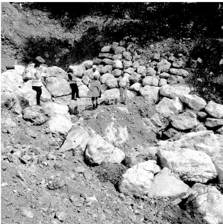
Abb. 6: Gebaute Stufen bei 15% Längsneigung im Betelriedgraben. Abnahme der Musterstrecke im Mai 2022.
