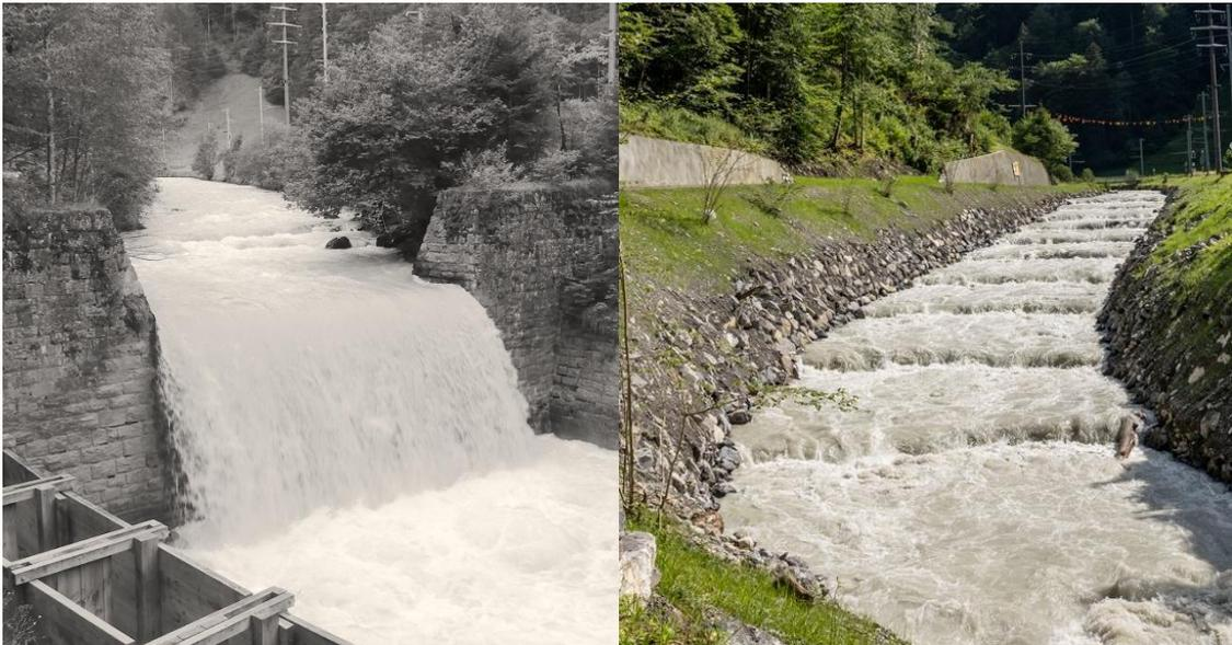
Abb. 5: Alte Betonsperre (links) und Traversensystem kurz nach Fertigstellung (rechts) im Mai 2022. Die Traversenfelder sind noch mit Sohlenmaterial gefüllt. Dieses wird mit den ersten Hochwasserabflüssen teils ausgespült werden (Bild: David Birri).
